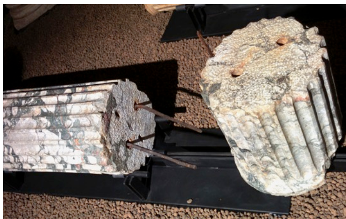
fig. 5 Struttura interna in ferro in una colonna del teatro romano di Priverno.
