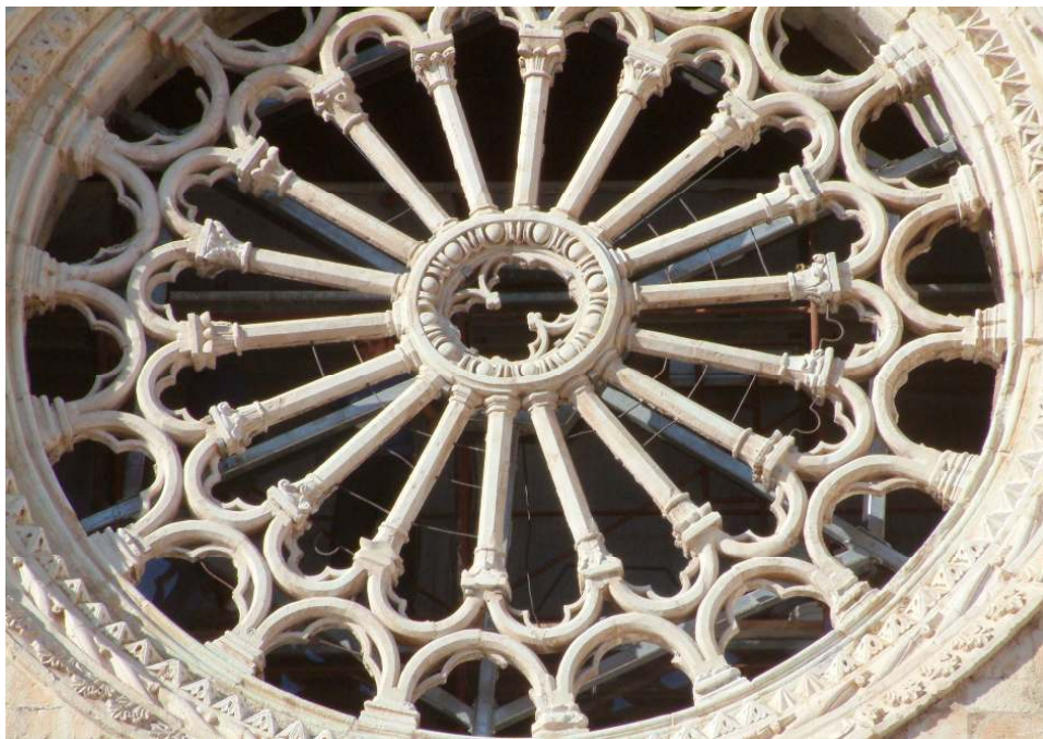
Figura 7. Il rosone dopo l'intervento di restauro
