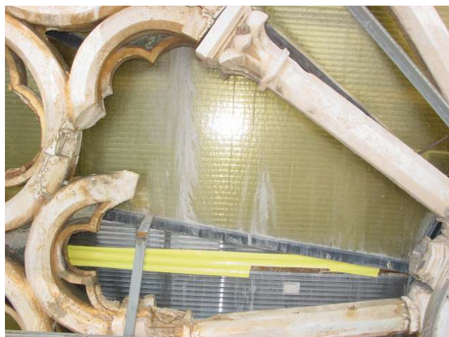
Figura 4. Lo smontaggio di una colonnina durante l'intervento di restauro
