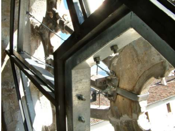
Figura 5. La struttura con una ganascia ed i tiranti che agiscono sul nucleo
