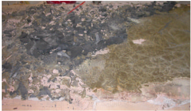
Particolare della rimozione lastra di ardesia
