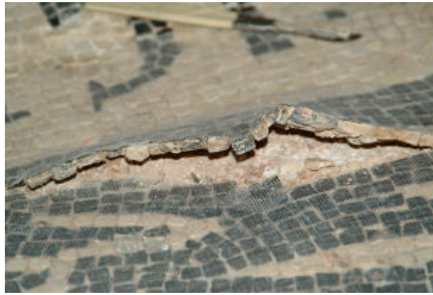
Sollevamento delle tessere per rinnovare l'adesione alla malta di allettamento
